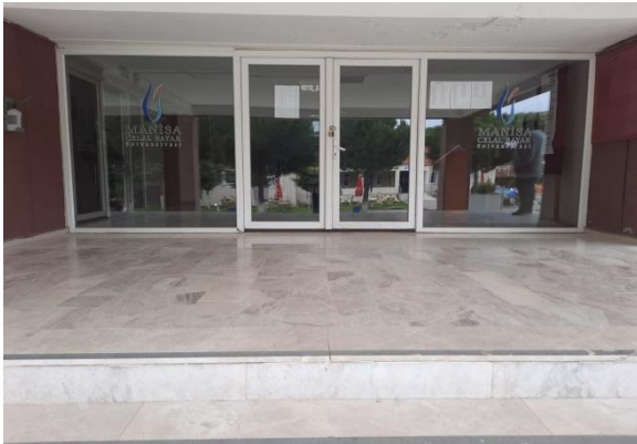
WA0006 (Derslik Binası Girişi)
