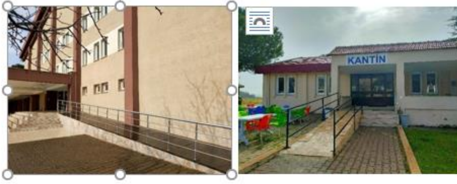
Resim 1. Yapı girişlerinde yer alan rampalar.
