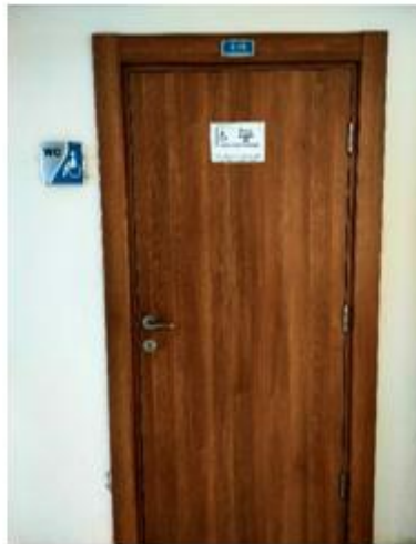
Resim 3. Derslik binasında bulunan engelli öğrenci tuvaletlerinden biri.
